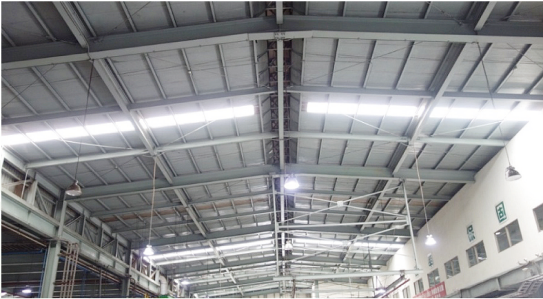
▲ 廠房屋頂增設透明板
