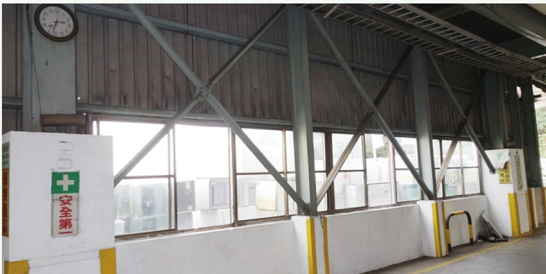
▲ 廠房增設對流透氣窗
