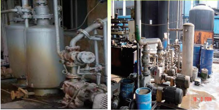
圖 3.3-10 密閉式冷凝水回收系統
